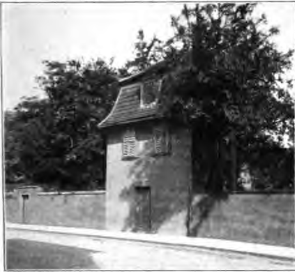
Oben: Ansicht der Mauer von Goethes Garten an der Alderwand. (Phot. Karl Schwier, Weimar.)
