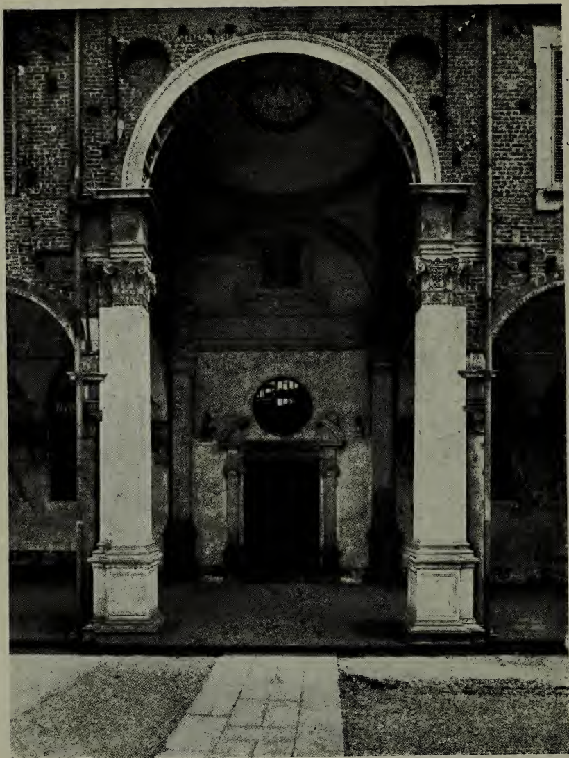
ARCO CENTRALE DELLA CANONICA DI SANT' AMBROGIO
