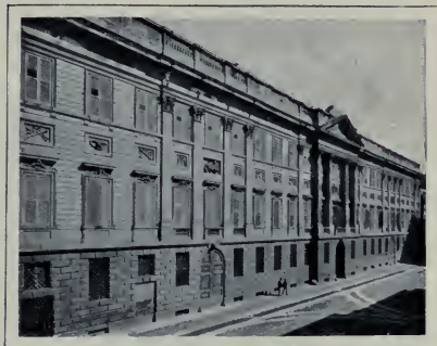
Abb. 368. G. Piermarini, Palazzo Belgiojoso (Mailand). (Brogi)
