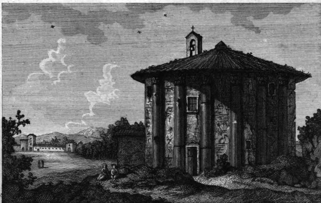
TEMPIO CREDUTO DI VESTA ▲
