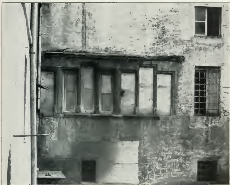
Bild 81: Gotische Fenstergalerie vom Hause des Johannes Burchard, Oberzeremonienmeisters Alexanders VI. (Via del Sudario 43—45).
