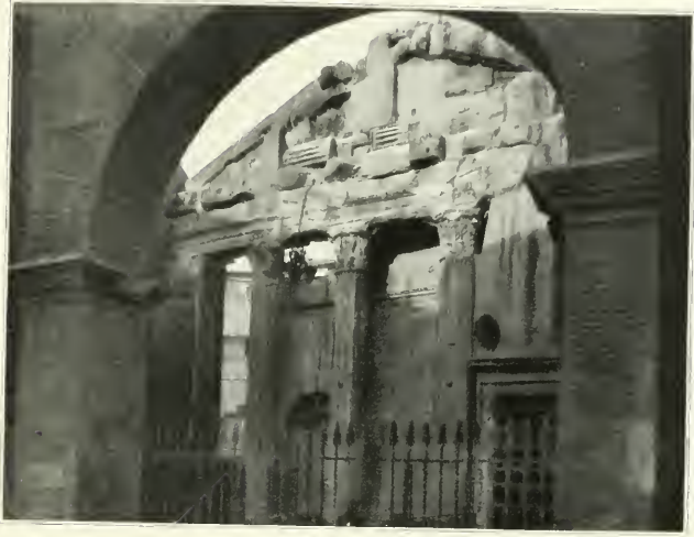
LE PORTIQUE D'OCTAVIE MONTRANT, DANS LA PARTIE SUPÉRIEURE, DEUX TRONÇONS DE COLONNE.
