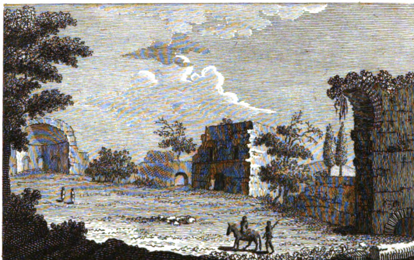
AVANZI DI ALTRE FABBRICHE NELLA VILLA ADRIANA
